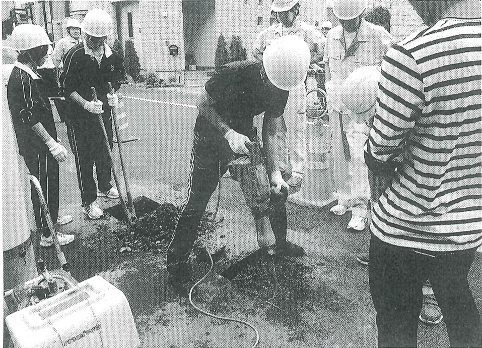
舗装されたアスファルトをはがし、土を掘り返す作業などを実践した
