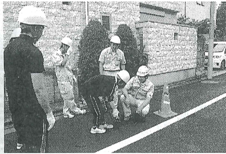
切り出したアスファルトを持ち上げる
