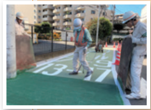
↓ 現場での作業風景
